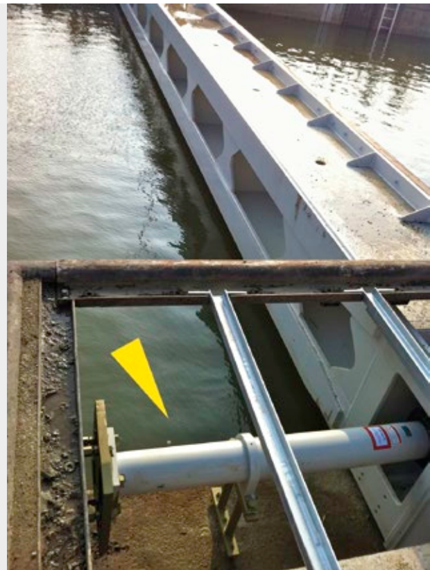
Speziell für diesen Einsatzfall ausgelegte schwere Sicherheitsstoßdämpfer bremsen in Schleuse Massen von bis zu vier Millionen kg ab Mourik Limburg BV, 6101 AJ Echt, Niederlande
